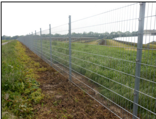
Abb. 7: Beispiel für eine Einfriedung um eine Photovoltaikanlage
